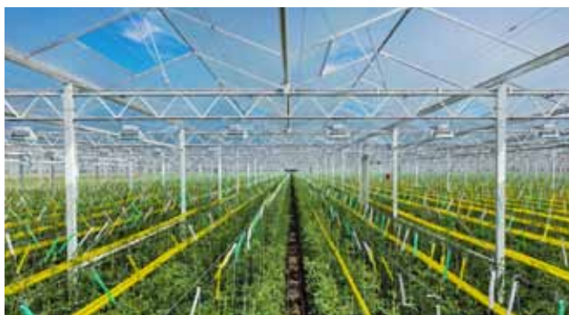
6.2 Lichte (verzinkte) stalen vakwerkliggers in een kas.
