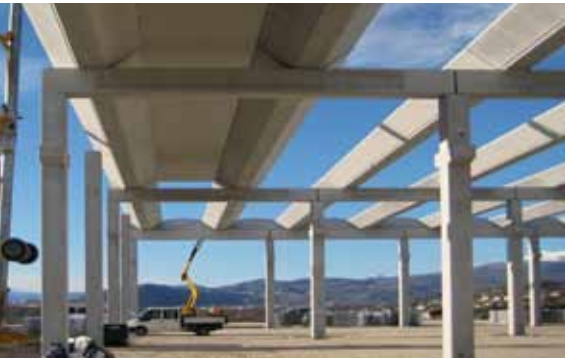
4.1 Geprefabriceerde betonnen hal in aanbouw.
