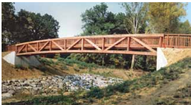
6.4 Houten vakwerkliggers voor een fietsers- en voetgangersbrug.
