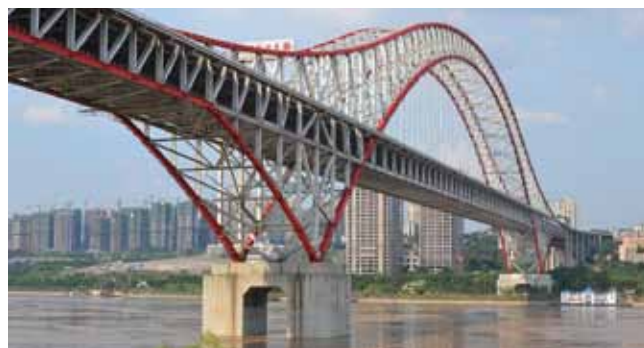
6.3 Chaotianman-brug over de Yangtze bij Chongqing (China): stalen vakwerkboogbrug met een overspanning van 552 m.
