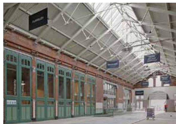
6.47 Kapsant uitgevoerd als Polonçeau-spant
