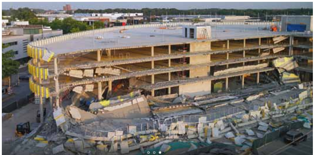
4.2 Ingestorte parkeergarage in Eindhoven (2017) doordat tijdens de bouw de inwendige krachten de materiaalsterkte overschreden.
