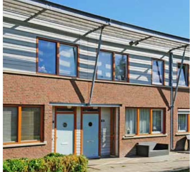
3.21 Latei boven de entree tot twee woningen in een woonblok.
