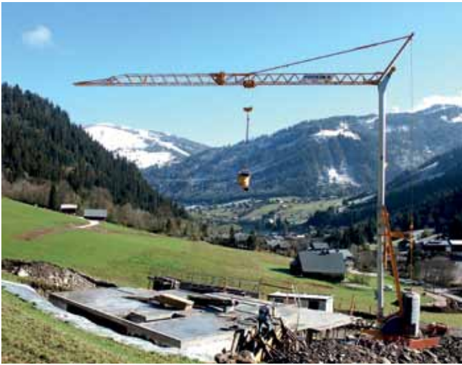
2.12 Bouwkraan met een kubel, gevuld met beton.
