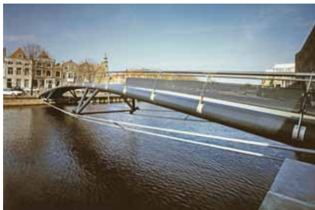
6.49 Onderspannen ligger van een voetgangersbrug in Middelburg.
