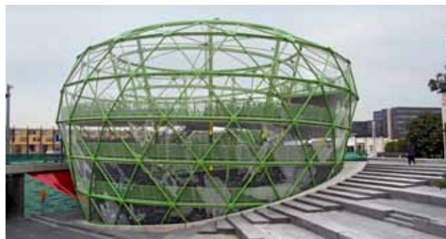
6.5 Ruimtelijk gekromd stalen vakwerk voor een fietsenstalling in Alphen aan de Rijn.
