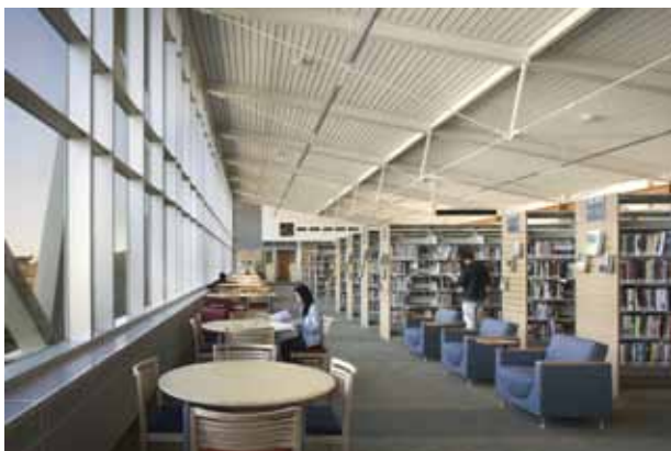
6.48 Onderspannen liggers voor het dak van een bibliotheek.
