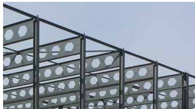
6.7 Raaatligger: een efficiënt materiaalgebruik.
