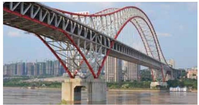
6.3 Chaotianman-brug over de Yangtze bij Chongqing (China): stalen vakwerkboogbrug met een overspanning van 552 m.
