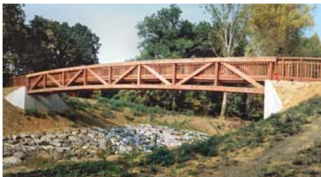
6.4 Houten vakwerkliggers voor een fietsers- en voetgangersbrug.
