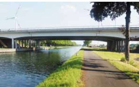
5.1 Viaduct in Maasmechelen over de Zuid-Willemsvaart, uitgevoerd als betonnen scharnierligger. De tandoplegging van de ingehangen ligger is het scharnier.
