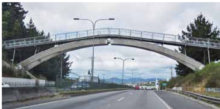
5.2 Houten driescharnierspant in boogvorm van een fietsersbrug.
