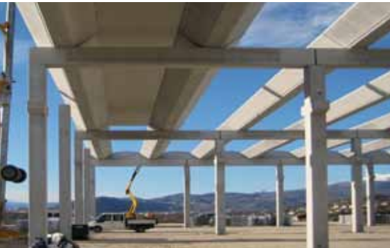
4.1 Geprefabriceerde betonnen hal in aanbouw.
