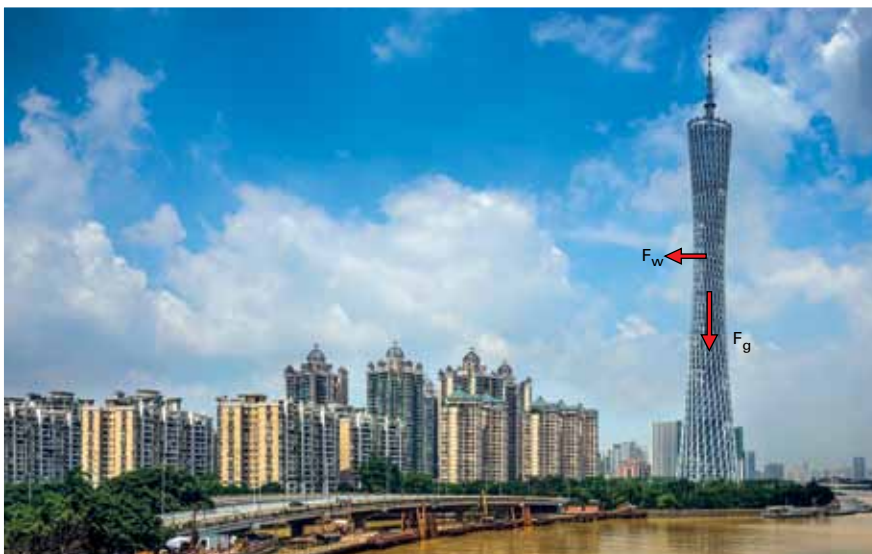
2.1 De 600 m hoge Canton Tower in Guangzhou (China) wordt zowel horizontaal (wind) als verticaal (eigen gewicht van constructie, inrichting en aanwezige personen) belast.
