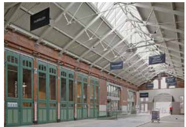
6.47 Kaspant uitgevoerd als Polonçeau-spant
