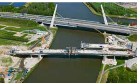
1.2 Nieuwe Betlebrug bij Muiden over het Amsterdam-Rijnkanaal. Ook tijdens de bouw moet een constructie in evenwicht zijn.
