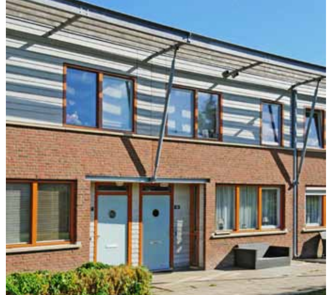
3.21 Latei boven de entree van twee woningen in een woonblok.
